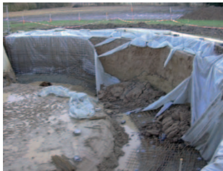
Fig. 1 A gauche, exemple de fouille dont la stabilité est inexplicable sur la base des méthodes de calcul et des paramètres de sol généralement recommandés. A droite, effondrement de fouille brutal et imprévu.
